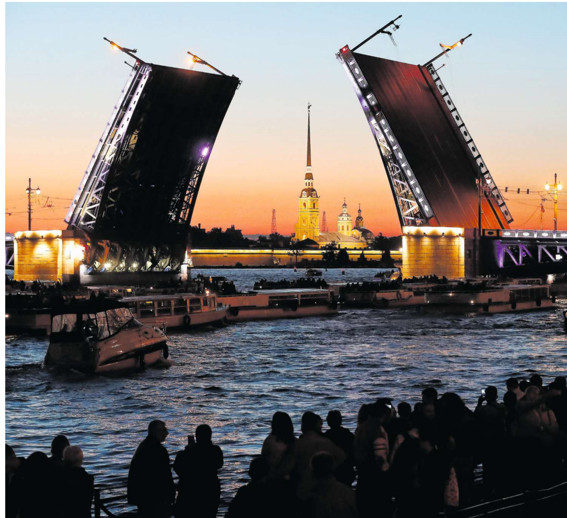
Insgesamt acht Brücken überspannen den breiten Strom der Newa. Sie lassen sich teilen und hochziehen, wenn grosse Schiffe durchfahren, also vor allem nachts.
